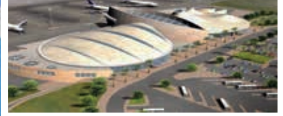
Sharm El Sheikh Airport, Egypt Dar Al Handasah
